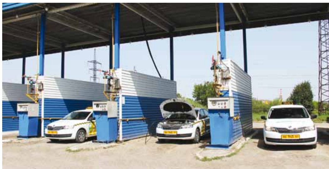
Заправка автомобилей природным газом на АГНКС-2
