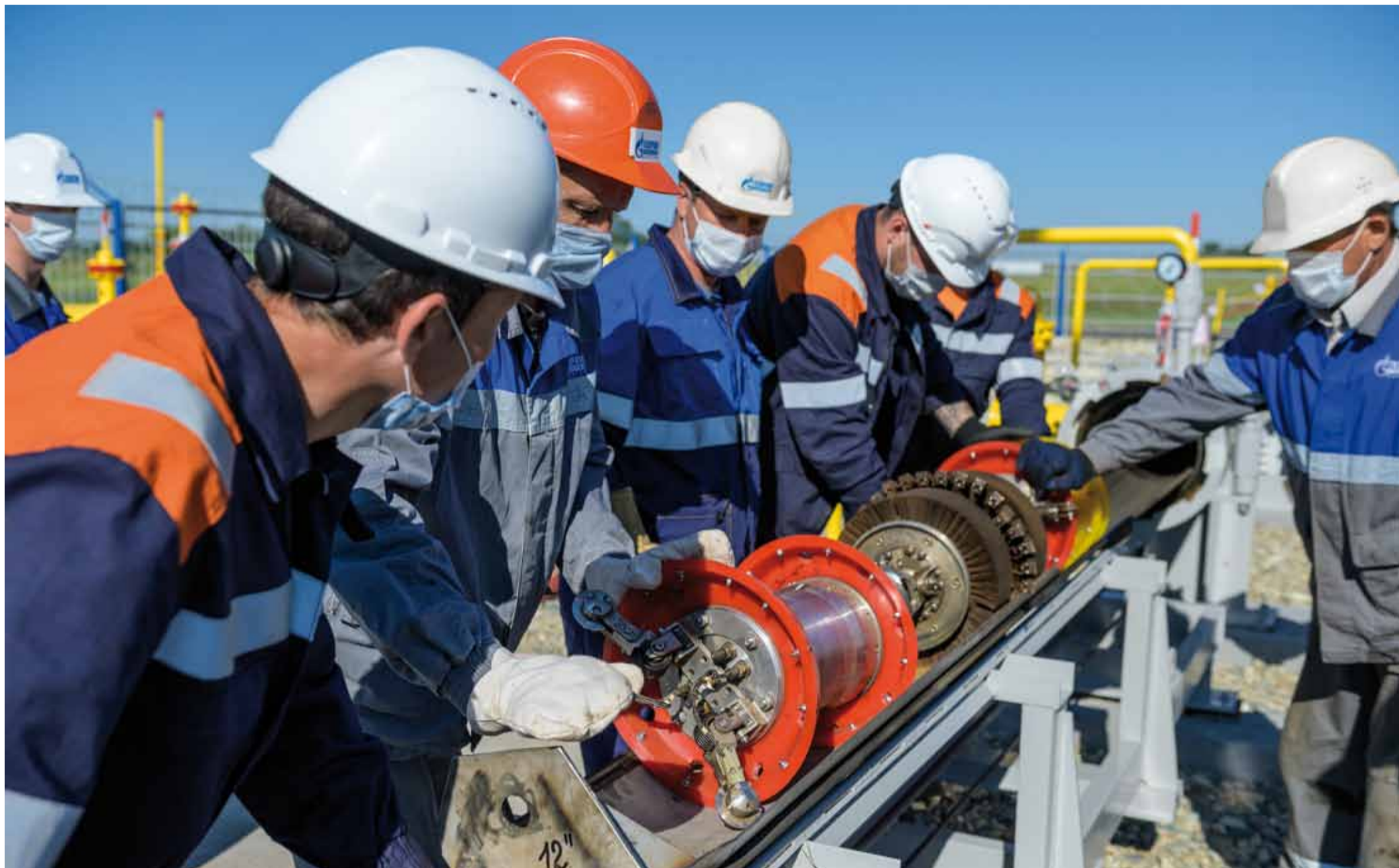
Запасовка внутритрубного устройства в камеру запуска магистрального газопровода Саратов – Москва. Ртищевская промплощадка Сторожевского ЛПУМГ
