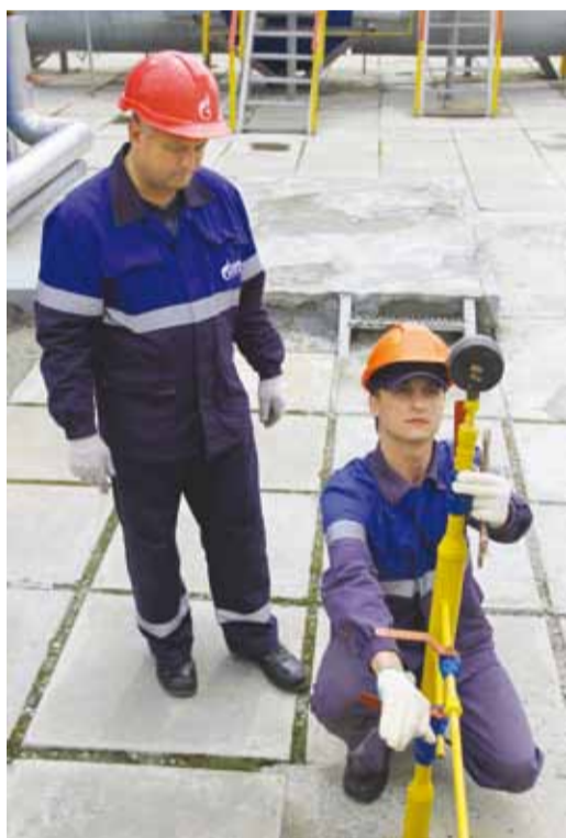
Замена манометра на стоянке импульсного газа
