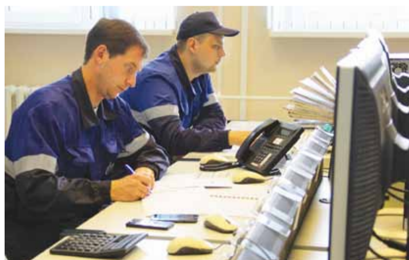
Главный щит управления КС «Новопетровская»
