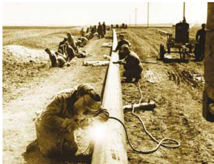
На строительстве газопровода Саратов – Москва. Саратовская область. 04.06.1945г.
