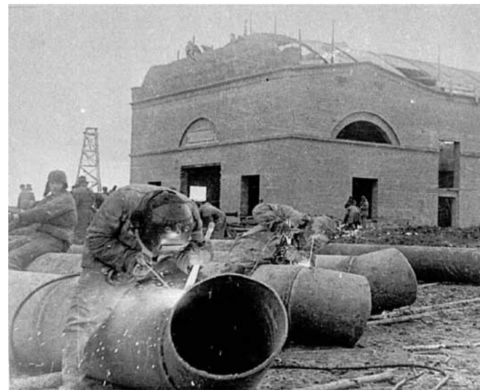
Сварочные работы на шестой компрессорной станции «Гавриловская». 1946 г.
