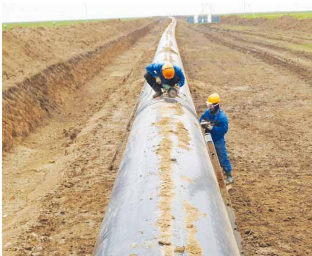
Подготовительные работы к капитальному ремонту участка магистрального газопровода САЦ-3
