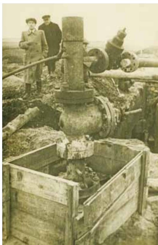
Горловина первой елшанской промышленной скважины («бабушки»)»
