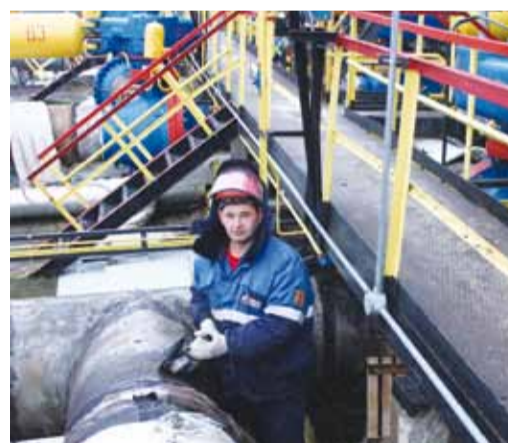
Подготовительные работы по проведению экспертизы промышленной безопасности сосудов высокого давления
