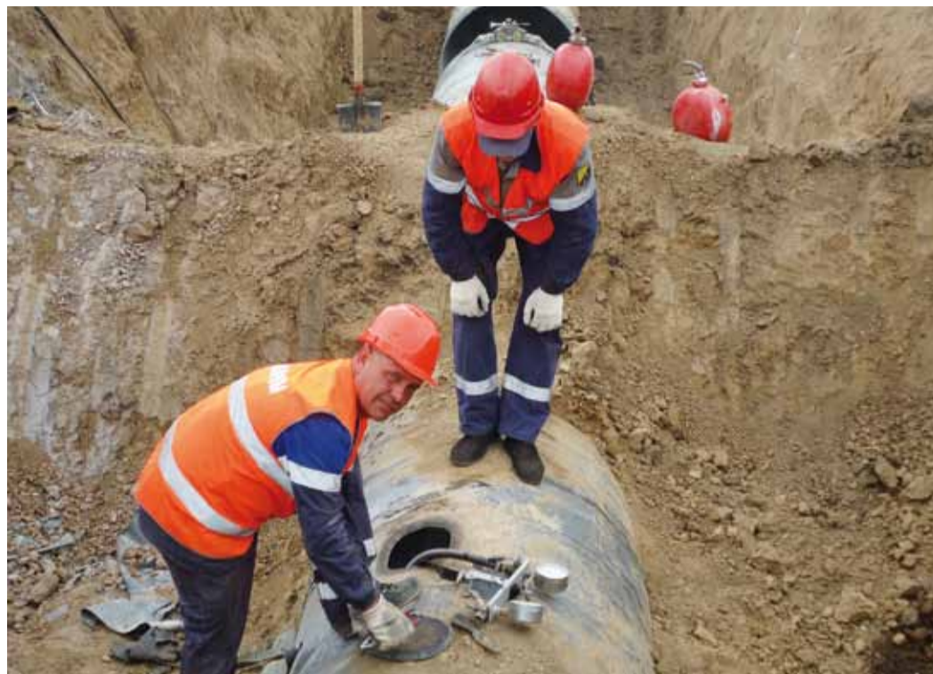
Замена дефектного участка на газопроводе «САЦ-2» (лупинг)
