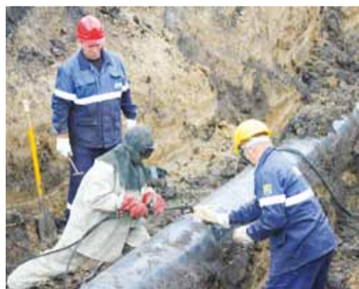
Ремонт подводных переходов на газопроводе-отводе ГРС Каменка
