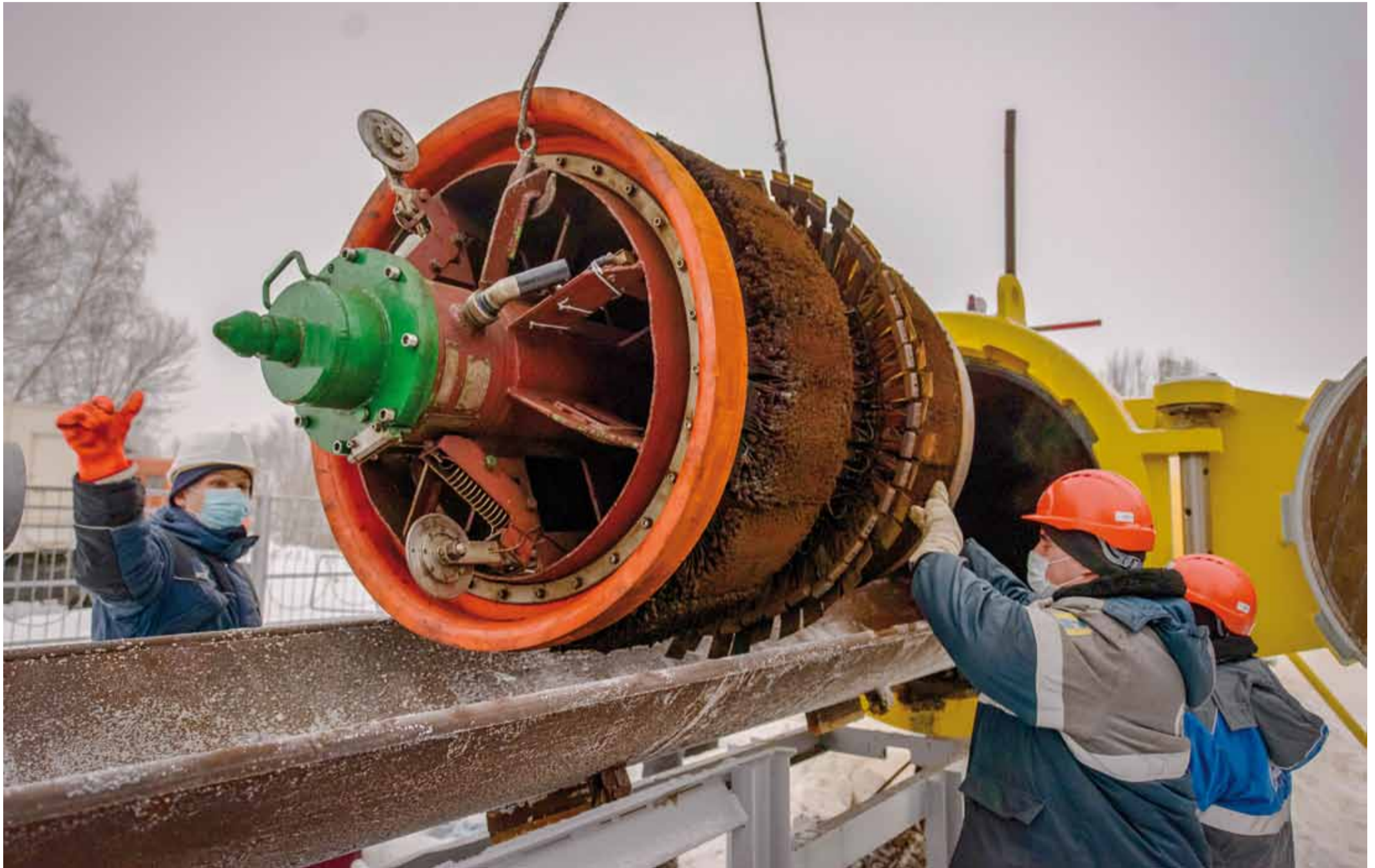
Работы на камере запуска диагностических устройств в Петровском ЛПУМГ
