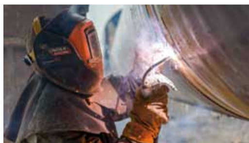
Сварка очередного стыка
