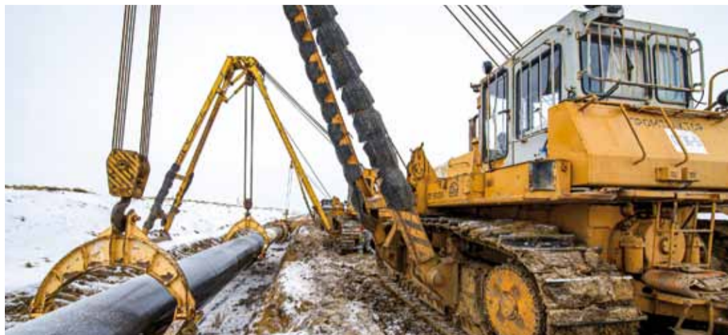
В плане работ 2021 года – капитальный ремонт 17,8 км магистрального газопровода Оренбург – Новопсков
