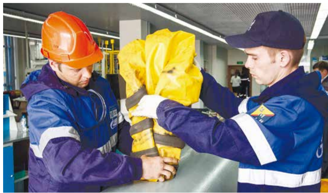
А так в «сдутом» состоянии шар помещают в газопровод с помощью технологического отверстия в трубе
