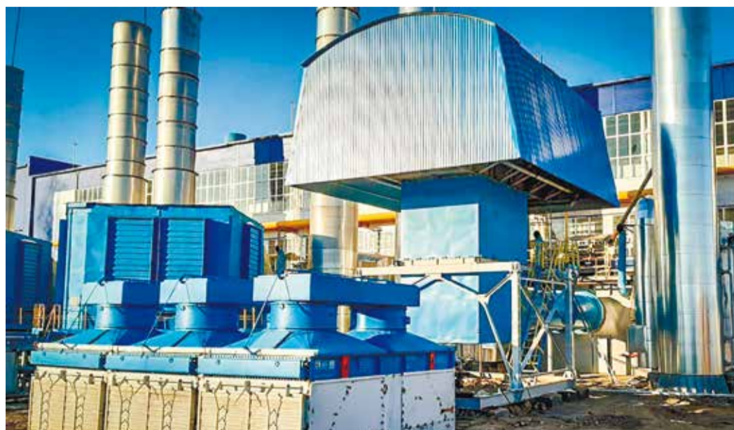
Работы в компрессорном цехе №1 Мещерского ЛПУМГ
