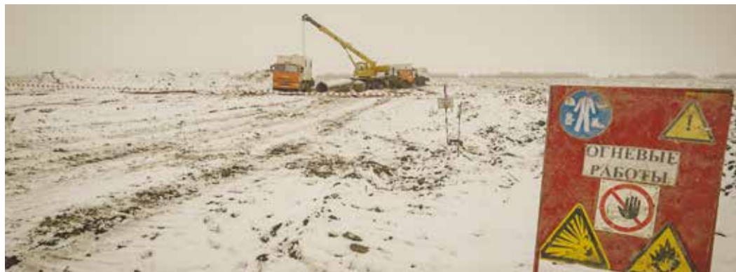
Работы на МГ САЦ-1 в зоне эксплуатационной ответственности Мокроусского ЛПУМГ
