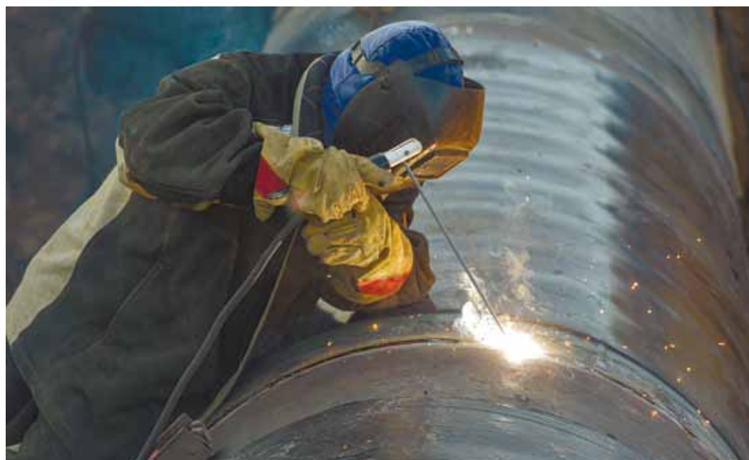
Огневые работы в Башмаковском ЛПУМГ
