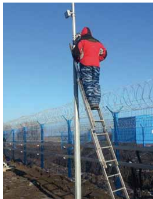
Монтаж системы охранного телевидения на узле подключения
