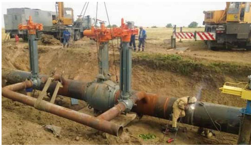
Ремонтные бригады УАВР производят монтаж временных камер приема очистных устройств на газопроводе «САЦ-2 - лупинг» Башмаковского ЛПУМГ
