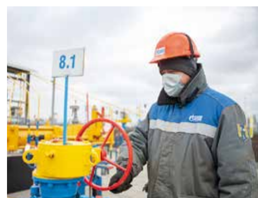
Проверка запорной арматуры на узле подключения
