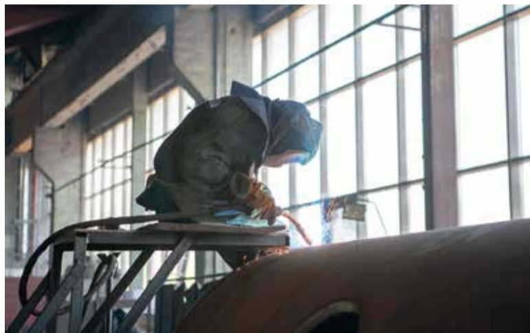
Сварочные работы на пылеуловителе циклонного типа
