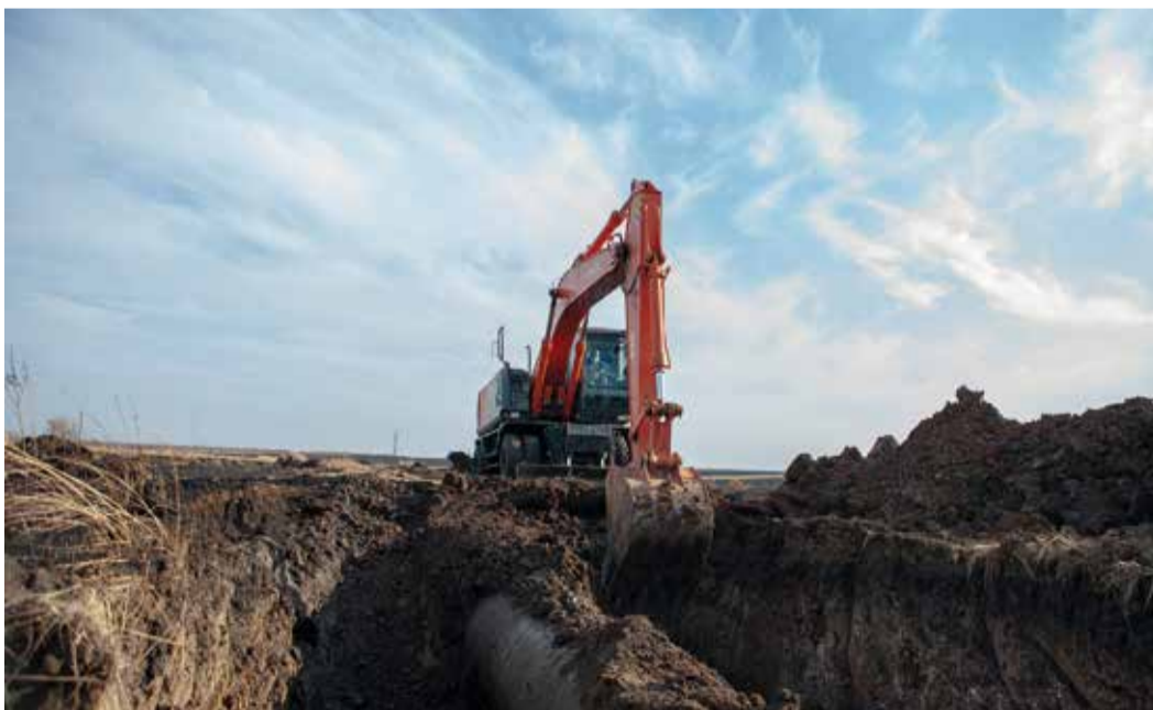
Земляные работы на МГ Петровск – Елец (расширение)
