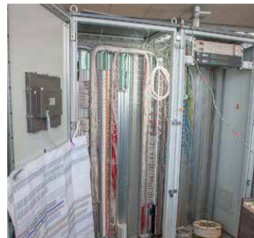
Сборка системы автоматического управления ГРС
