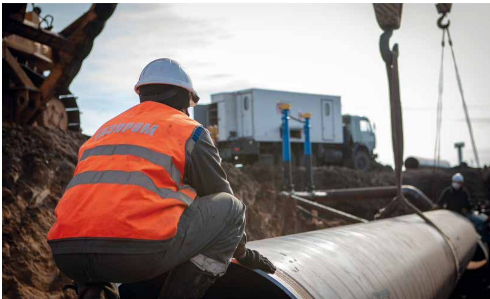
Монтаж трубы ДУ 1220 мм на узле подключения КЦ-3 Мещерского ЛПУМГ
