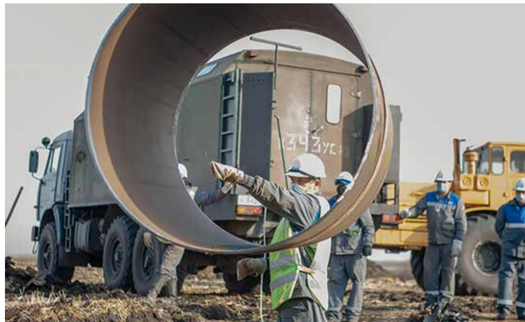
Подготовка к установке «катушки»
