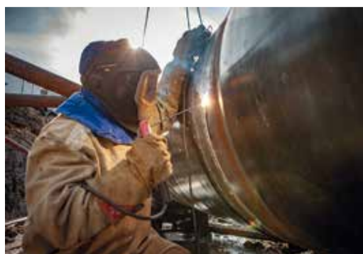
Сварка крана ДУ 1220 мм
