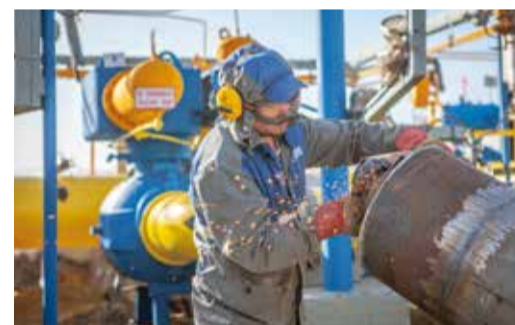
Подготовка отвода к сварке
