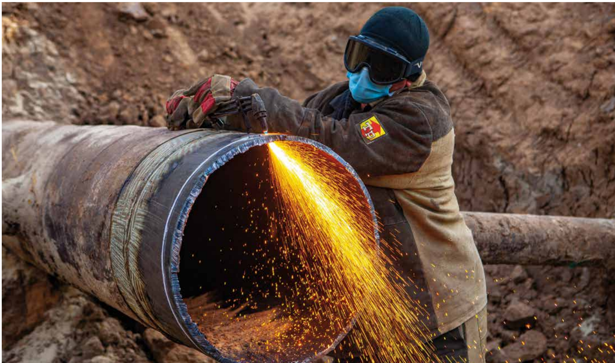
Электрогазосварщик 6 разряда УАВР Алексей Никифоров выполняет чистовой рез газопровода
