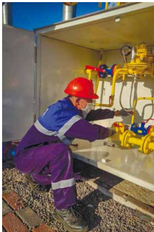
Подготовка подогревателя газа к пуску
