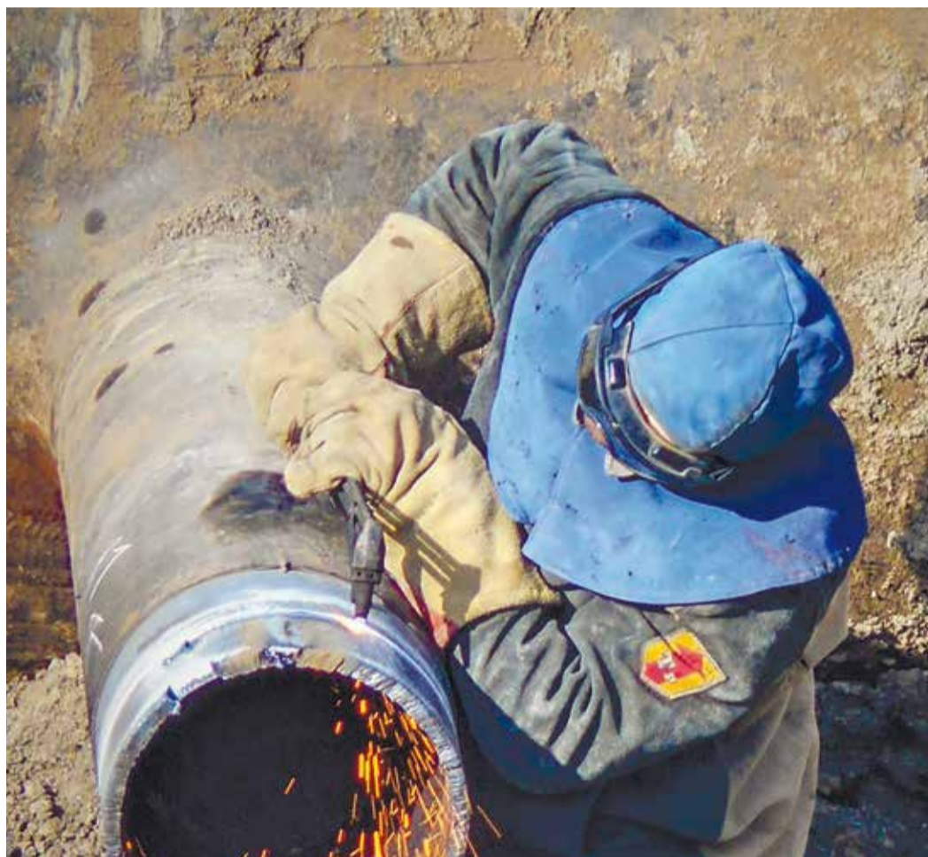
Электрогазосварщик 6 разряда УАВР Алексей Пузик выполняет чистовой рез под сварку стыка
