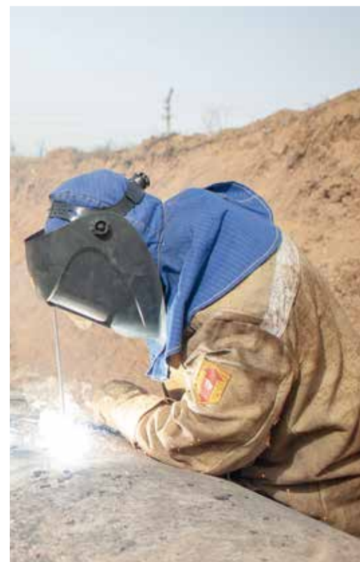
Сварка очередного стыка
