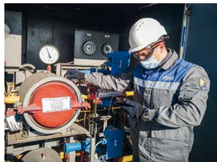
Техническое диагностирование фильтров очистки газа ГРС
