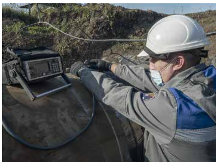
Качество сварных стыков - основа надежности транспорта газа
