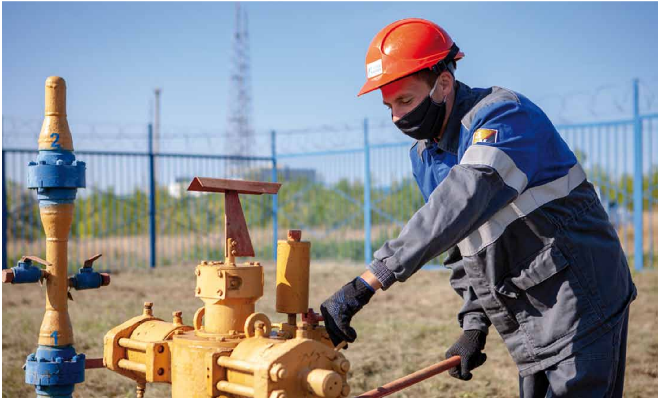
Трубопроводчик линейный 4 разряда Сторожевского ЛПУМГ Владислав Евдокимов заполняет камеру приема очистных и диагностических устройств до рабочего давления газопровода
