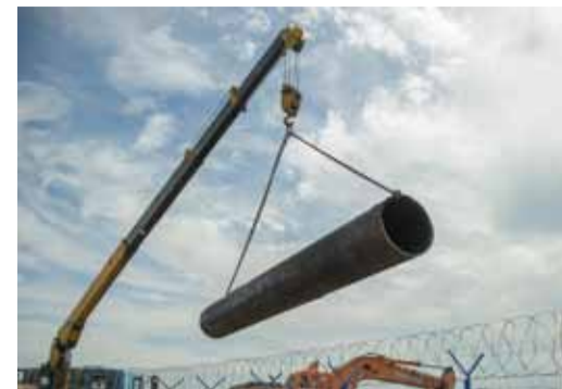
Перемещение демонтированной трубы
