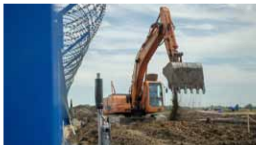
Экскаватор – незаменимый помощник в проведении КРТТ
