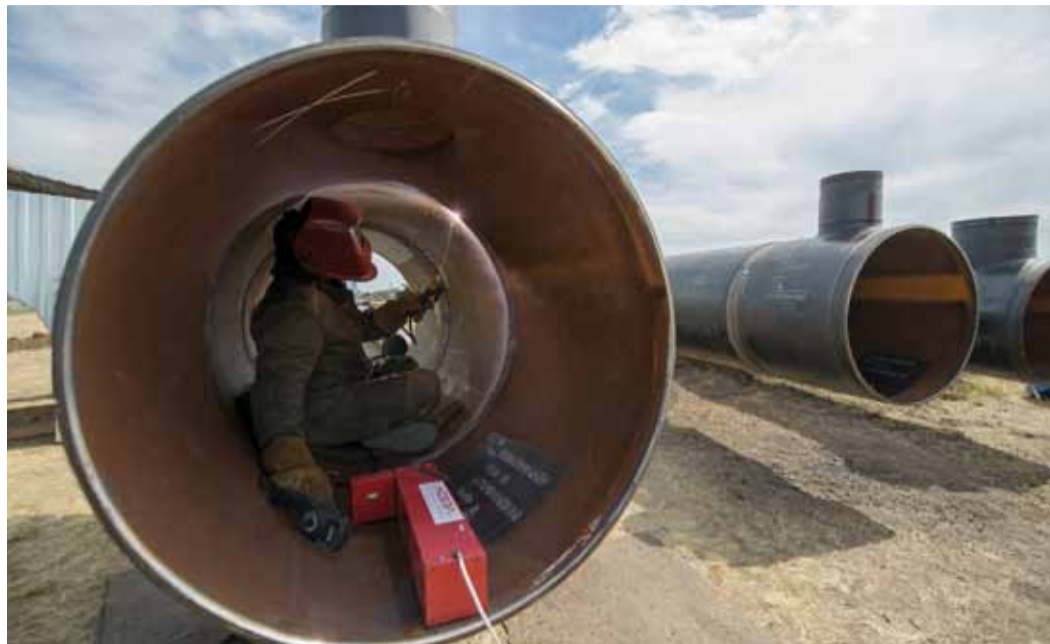
Сварка с подваром из трубы
