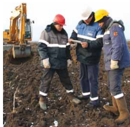
Специалисты ЛЭС: рекультивация земли после ремонта газопровода
