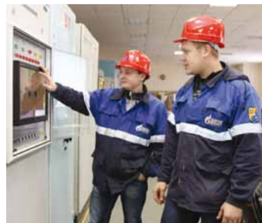
Приборист КИПиА И.Белков и слесарь Л.Жидов: проверка систем пожарной охраны на ГЩУ
