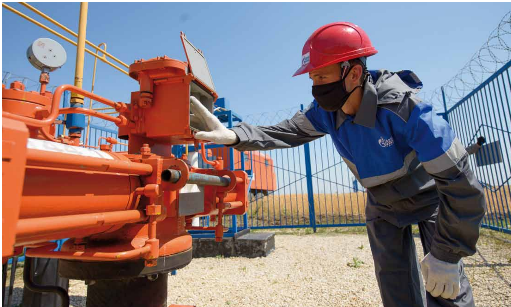
Плановое техническое обслуживание ТПА линейного крана на 144 км магистрального газопровода Мокроус – Самара – Тольятти. Иван Капелин, линейный трубопроводчик 4 разряда.
