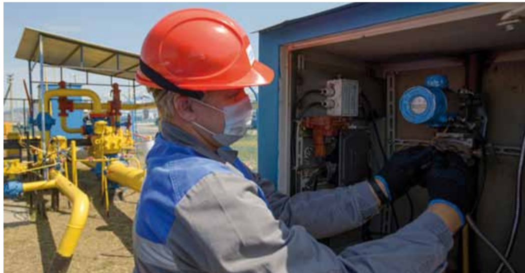
Замена прибора учета расхода газа Гипер Флоу-3 Пм. АГРС «Пугачев». Антон Морозов.
