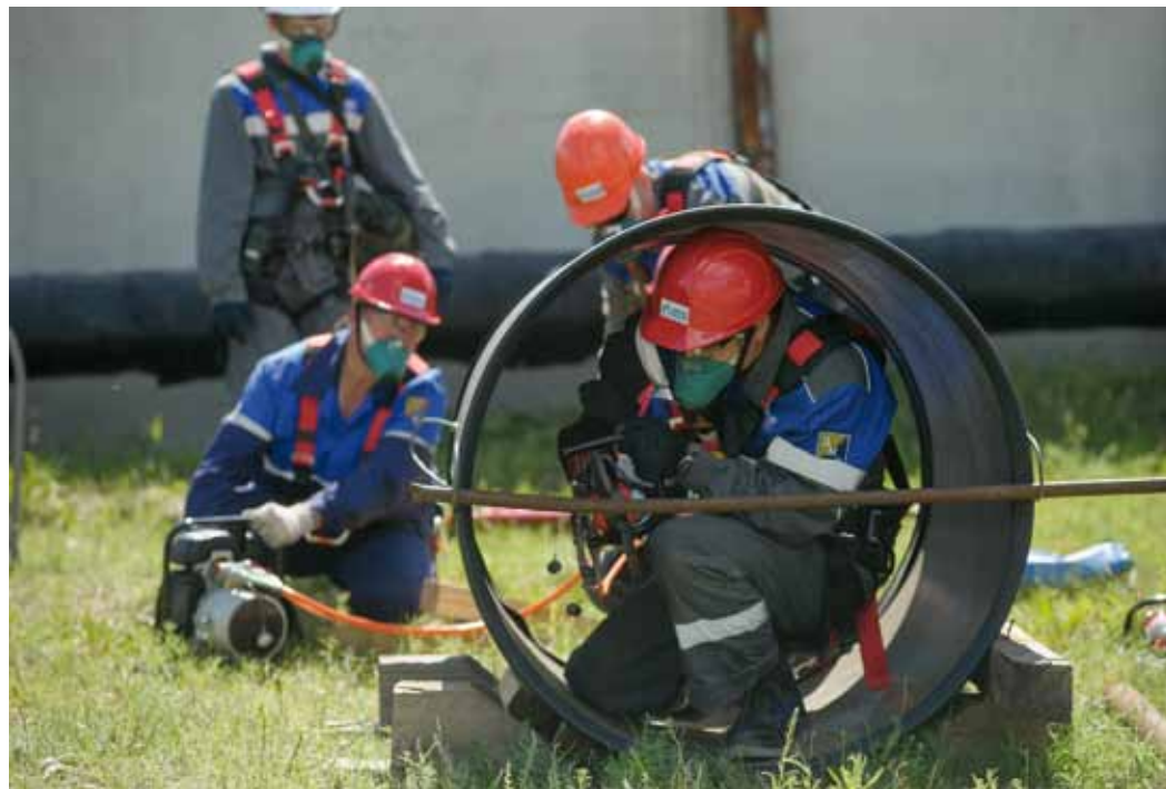
Преодоление преграды при помощи гидравлических ножниц
