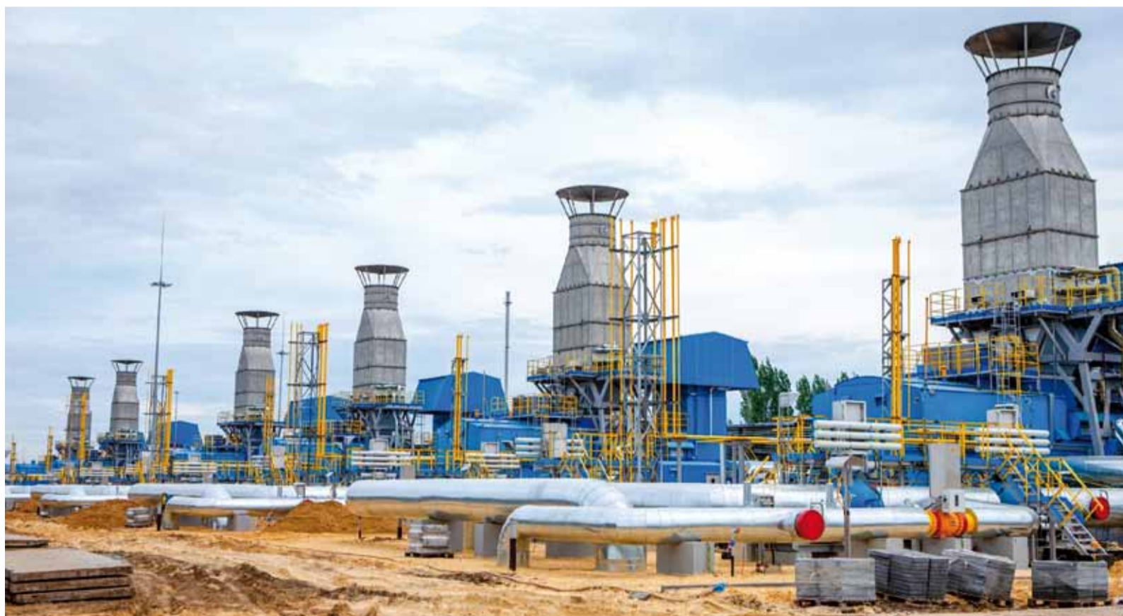
Реконструкция компрессорного цеха №4 Петровского ЛПУМГ
