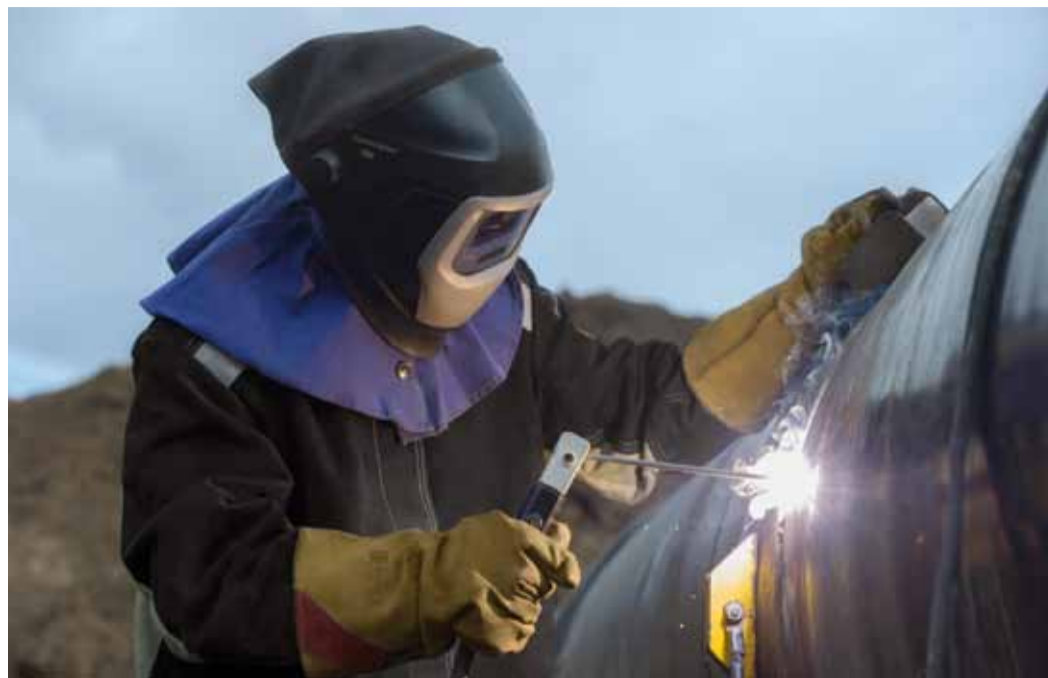
Осневые работы в Мокроусском ЛПУМГ
