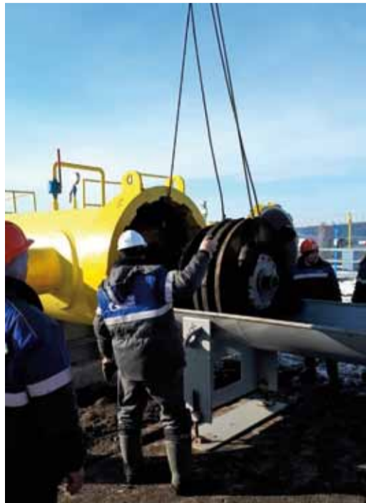
Запасовка снаряда в Башмаковском ЛПУМГ
