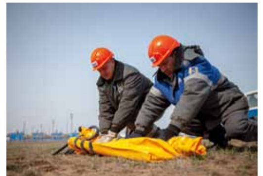
Подготовка временного герметизирующего устройства
