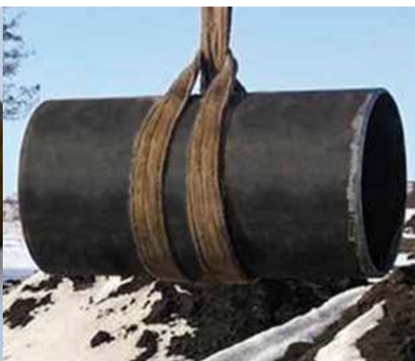
Катушка с нитками и «катушка» для участка «нитки» магистрального газопровода
