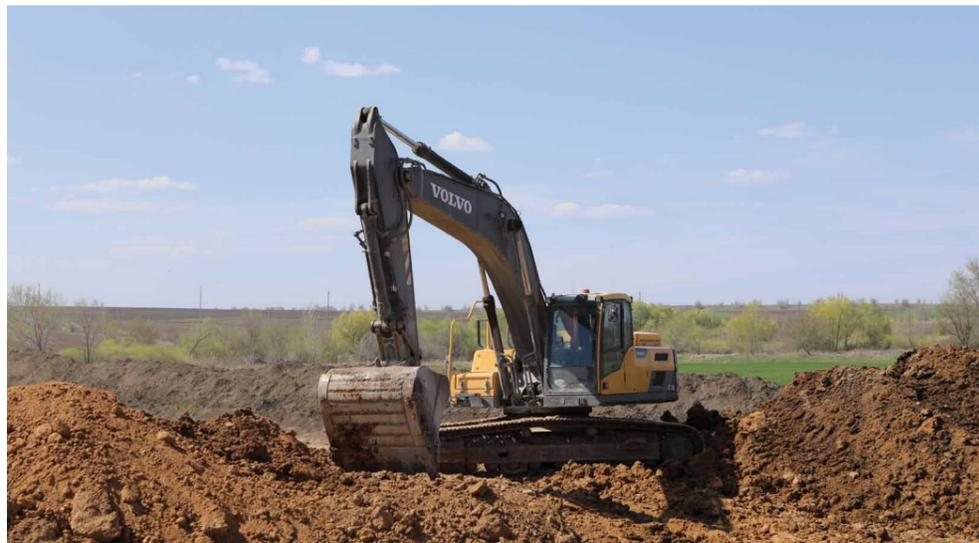
■ Для прокладки автодороги и переустройства коммуникаций специальная техника снимает до 12 метров грунта
