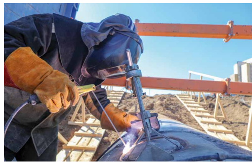
Сварка технологического отверстия
