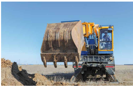
Начало земляных работ
