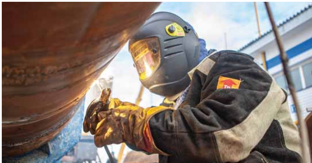
Огневые работы на компрессорном цехе №1
