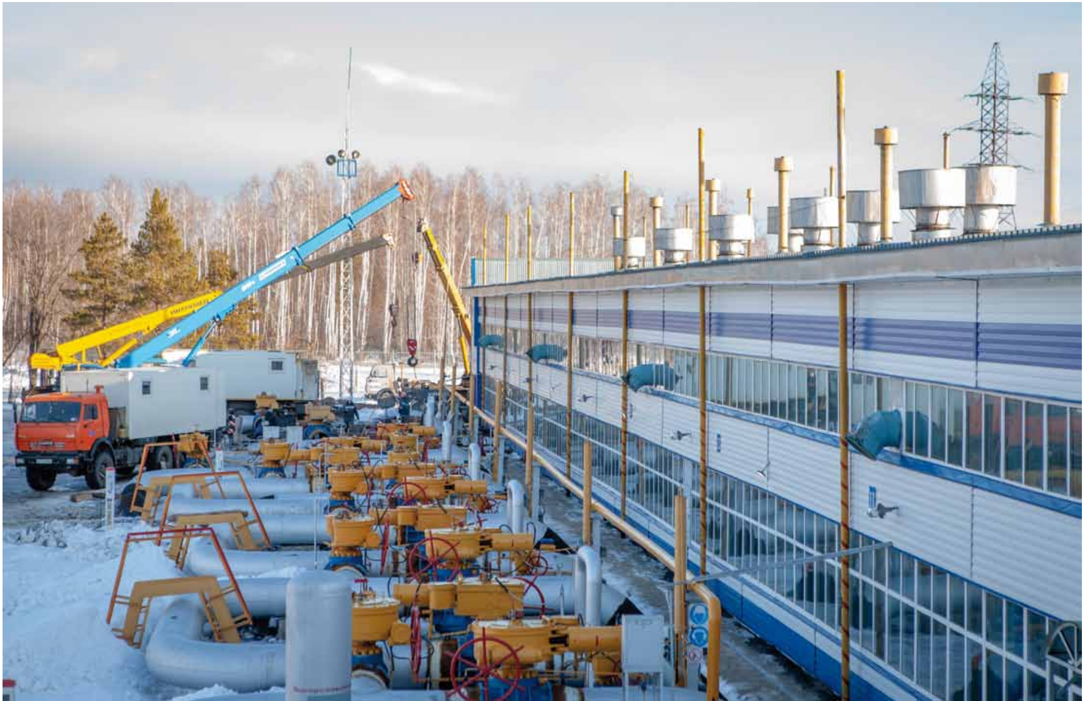
Капитальный ремонт технологической обвязки двух газоперекачивающих агрегатов компрессорного цеха №1 Петровского ЛПУМГ
