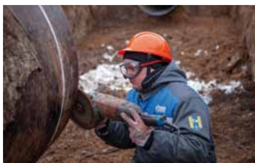
Подготовка кромки трубы
