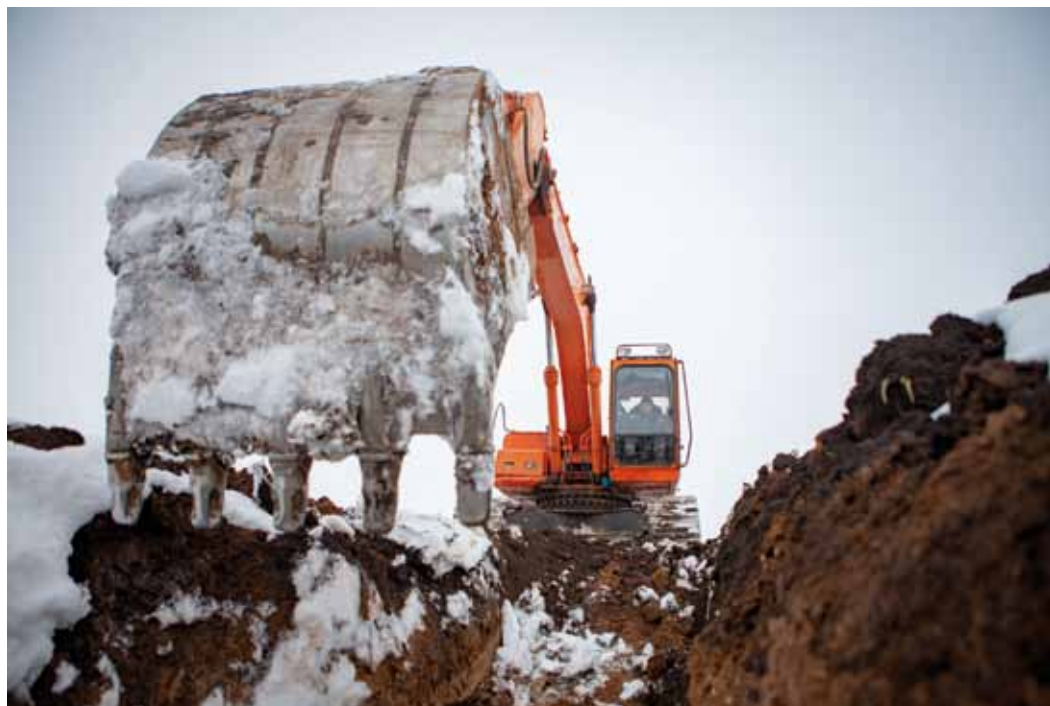
Начало земляных работ на одном из участков магистрального газопровода САЦ-2
