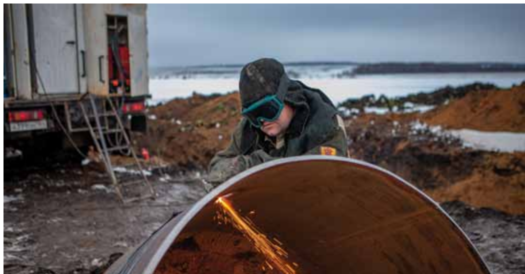
Вырезка технологического отверстия
