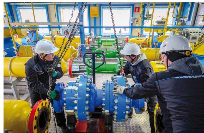
Монтаж регулятора
