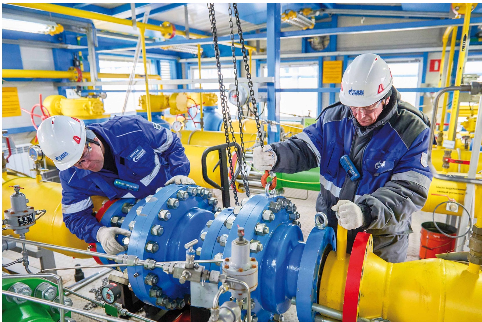
Проверка качества выполнения монтажа
