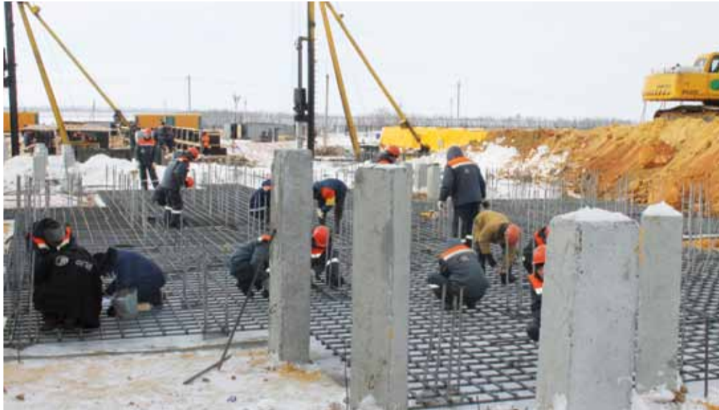
КС «Екатериновка»: ведутся работы по заливке фундамента под ГПА
