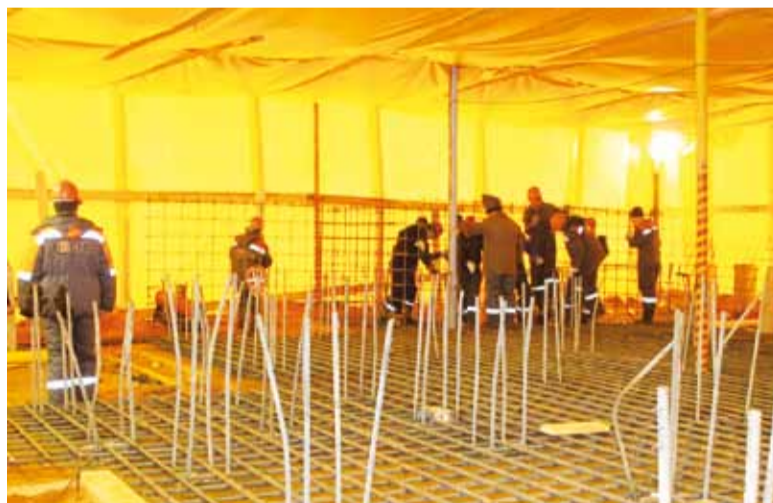
Подготовка фундамента под ГПА№4
