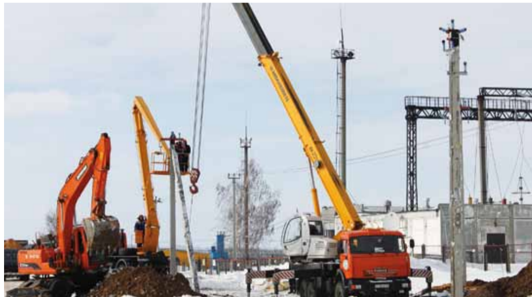
Установка опор под ЛЭП
