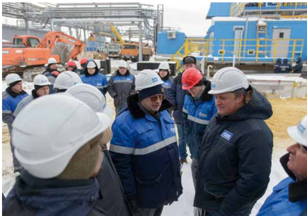
На площадке реконструкции компрессорного цеха №4
