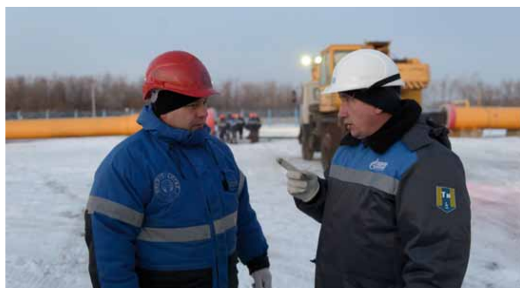
Главный инженер Екатеринбургского ЛПУМГ Дмитрий Савельев (справа) обсуждает детали проведения работ
