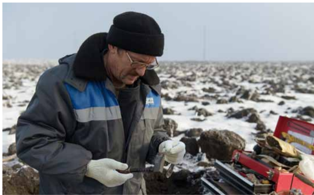
Ремонт медного кабеля
