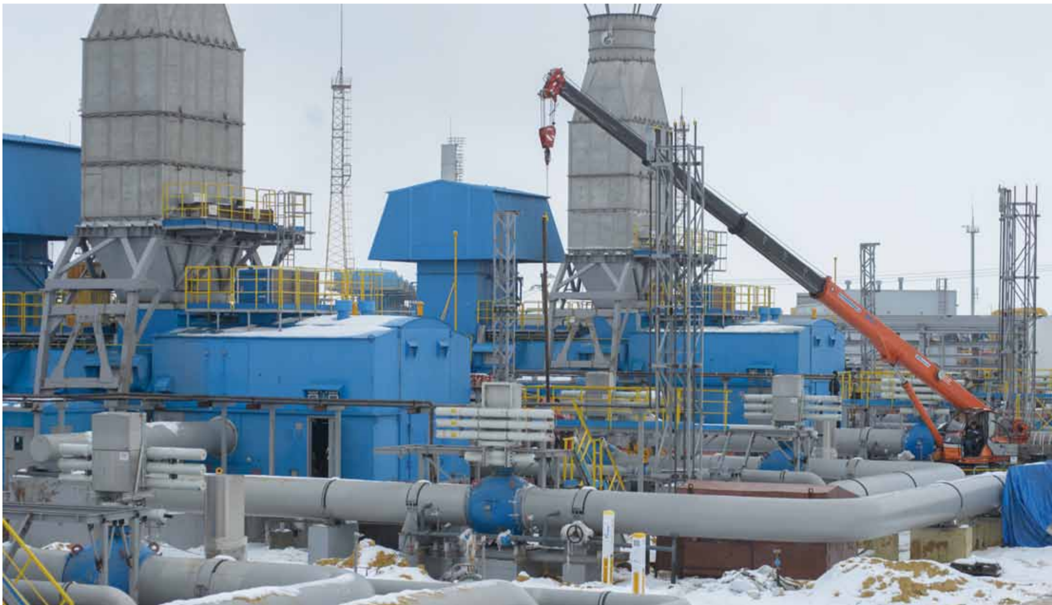
Уже скоро компрессорный цех будет впервые заполнен газом для проведения пуско-наладочных работ
