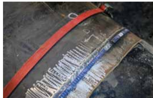
Очередной объект контроля работников ППЛ ИТЦ
