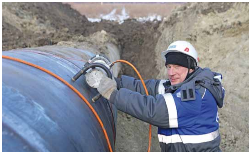
Дефектоскопист 6 разряда ИТЦ Николай Козлов осуществляет контроль сварного соединения
