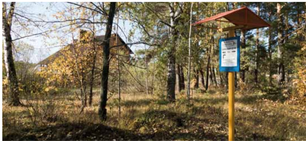
Нарушение охранной зоны магистрального газопровода Кирсанов – Тамбов, Кирсановское ЛПУМГ
