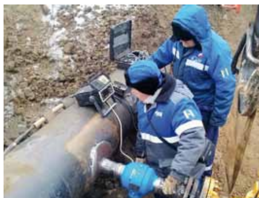
Неразрушающий контроль сварных соединений
