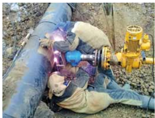
Приварка узла врезки
