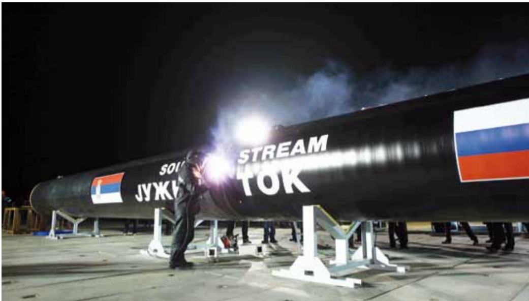
Сварка первого стыка. Фото с сайта ОАО «Газпром»
