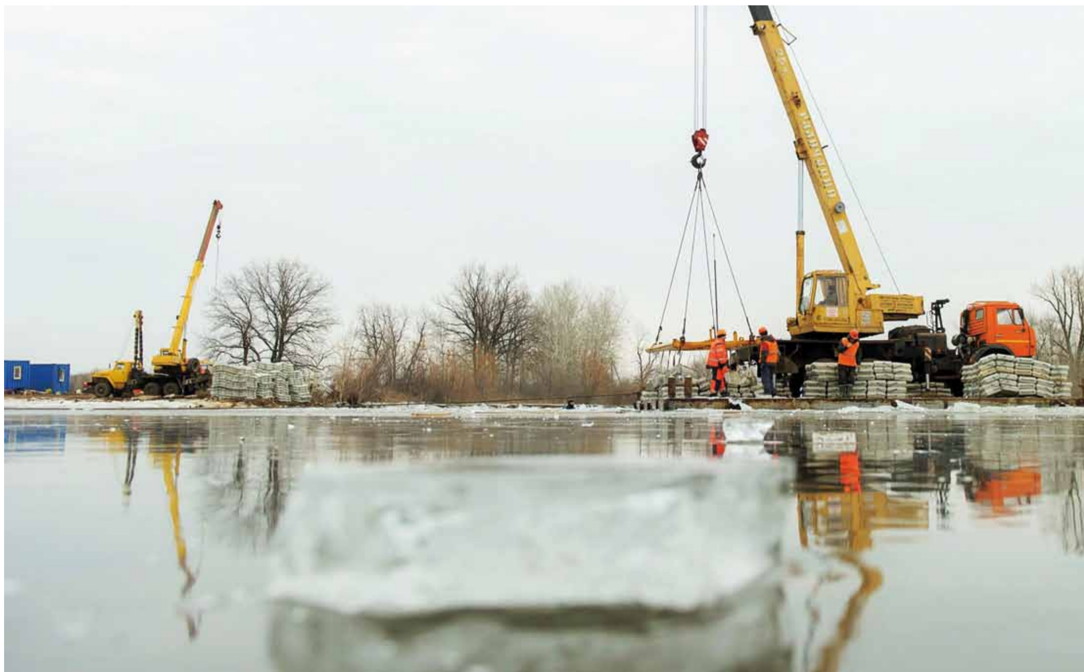
Ноябрьский ледостав не помешал ходу работ на участке магистрального газопровода САЦ-3 (1367-1368 км)
