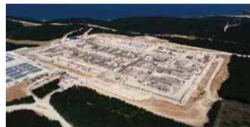
Приемный терминал для газопровода «Турецкий поток»
