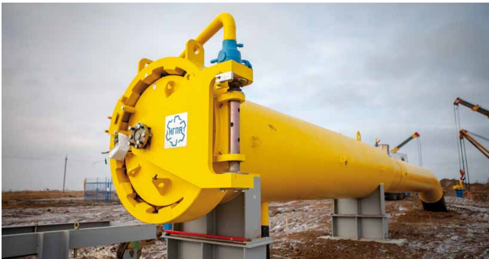
Новая камера приема очистных устройств магистрального газопровода САЦ-3
