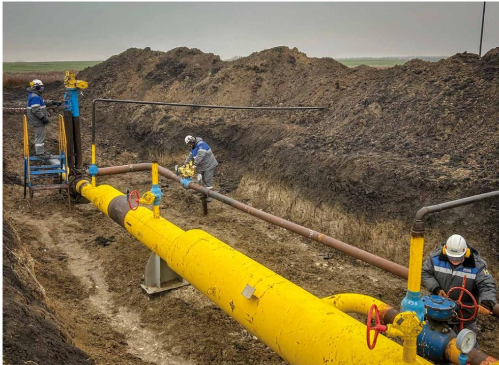
Работы по внутритрубной дефектоскопии на газопроводе Чижа-Озинки
