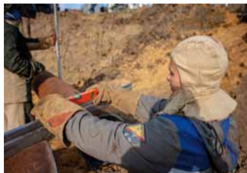
Выравнивание байпасной линии по уровню
