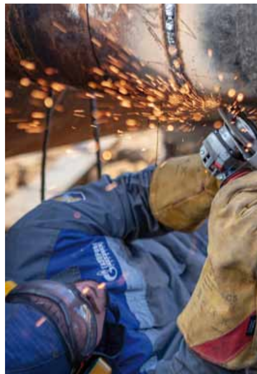
Зачистка облицовочного слоя шва
