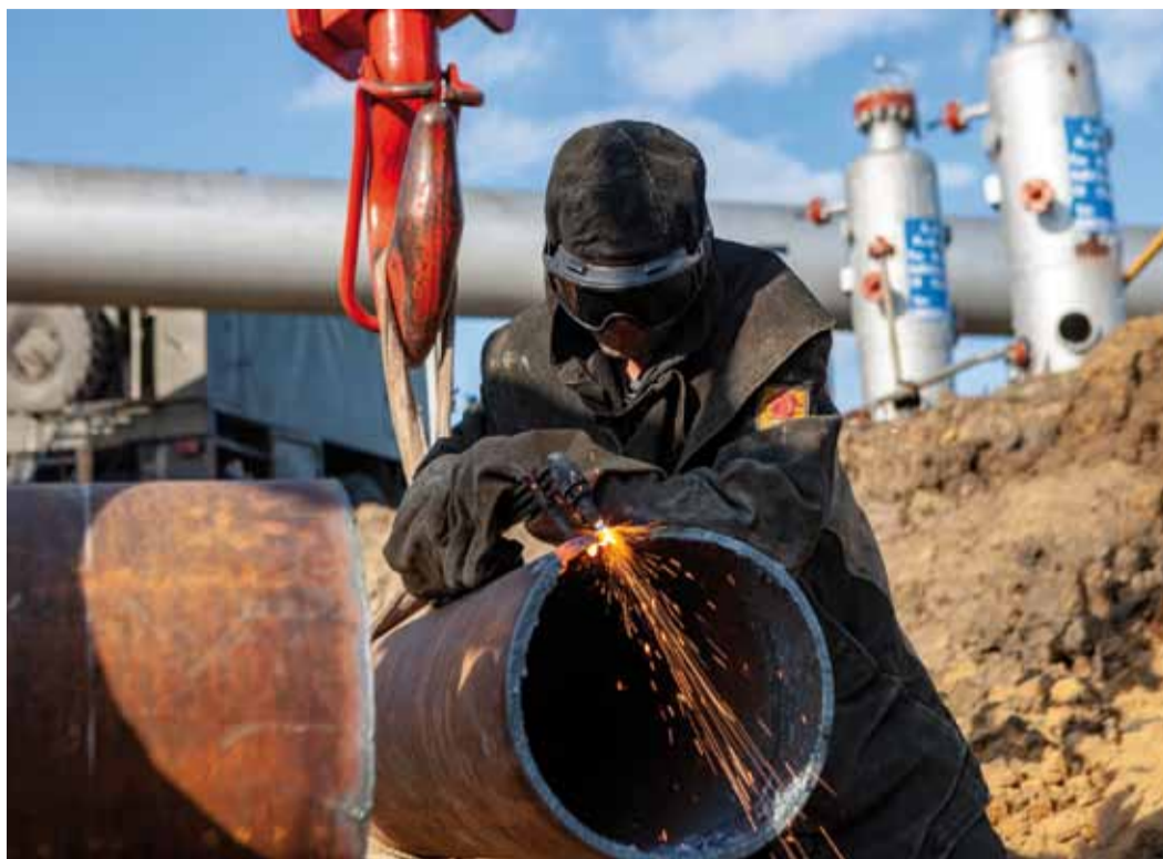
Чистовой рез трубы
