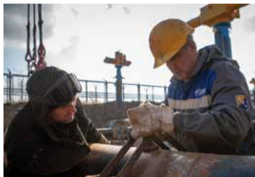
Установка центратора на стык
