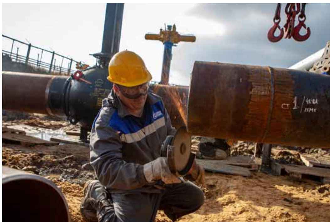
Зачистка кромки трубы
