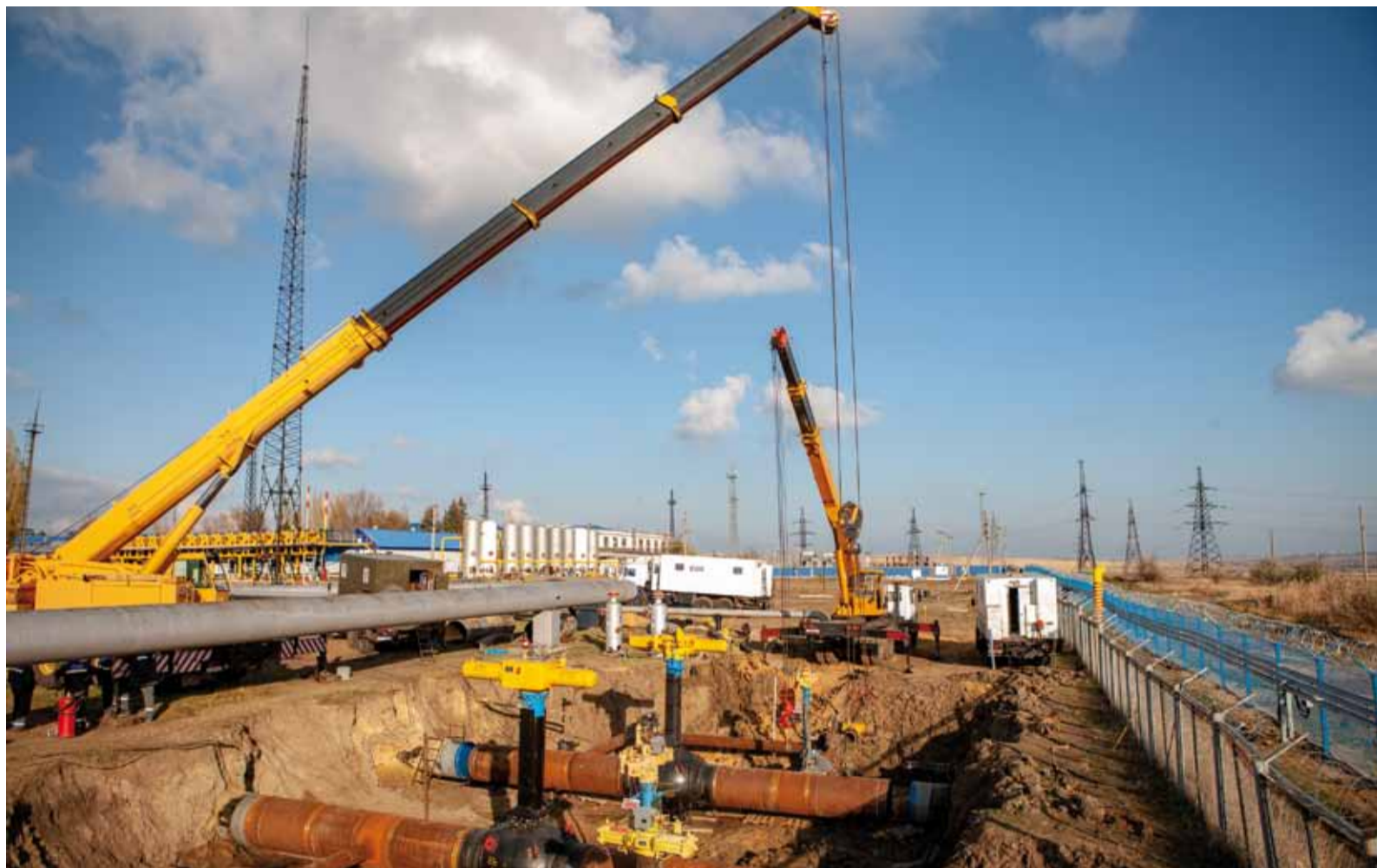
Капитальный ремонт позволит существенно повысить надежность транспортировки газа на стратегическом участке от Петровского ЛПУМГ до саратовских станций ПХГ
