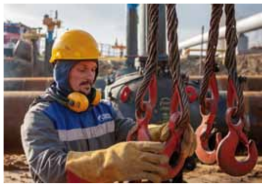
Подготовка к строповке трубы
