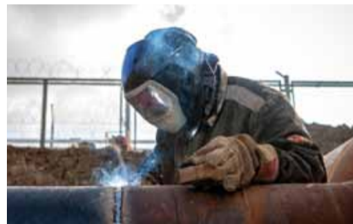
Сварка стыка
