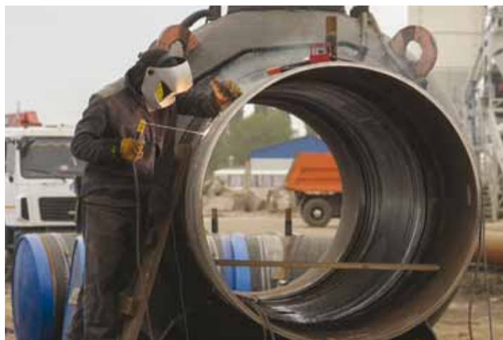
Работы на площадке КЦ №4 не прекращались даже во время совещания
