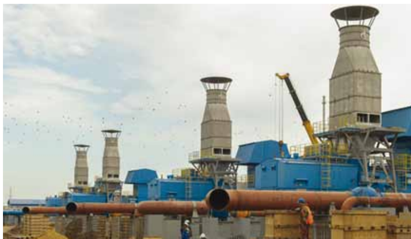
Строительная площадка компрессорного цеха №4 КС «Петровск»
