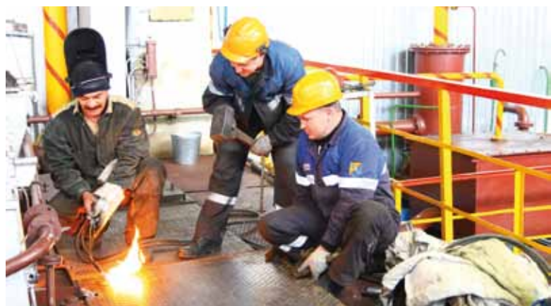
Ремонтные работы в турбоцехе Петровского ЛПУМГ
