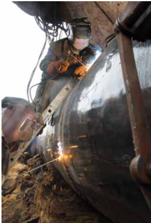
Сварка стыков, врезка катушек...
