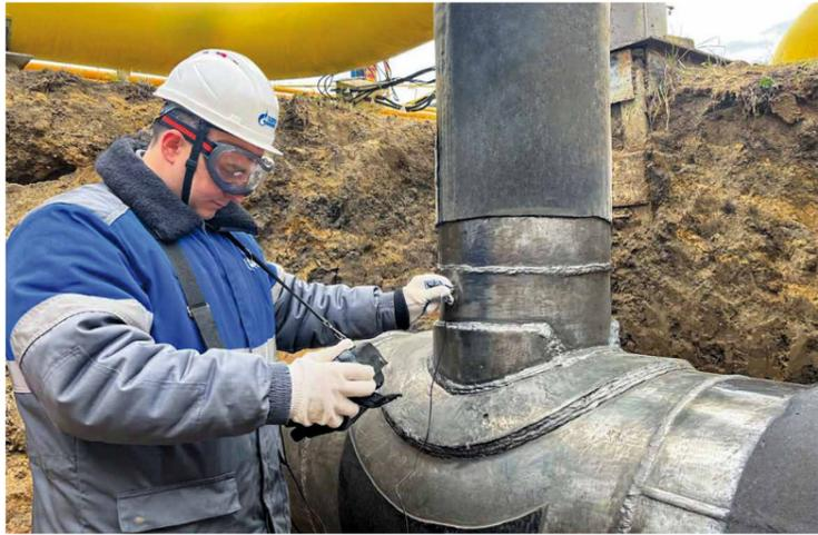
Проведение ультразвуковой толщинометрии
