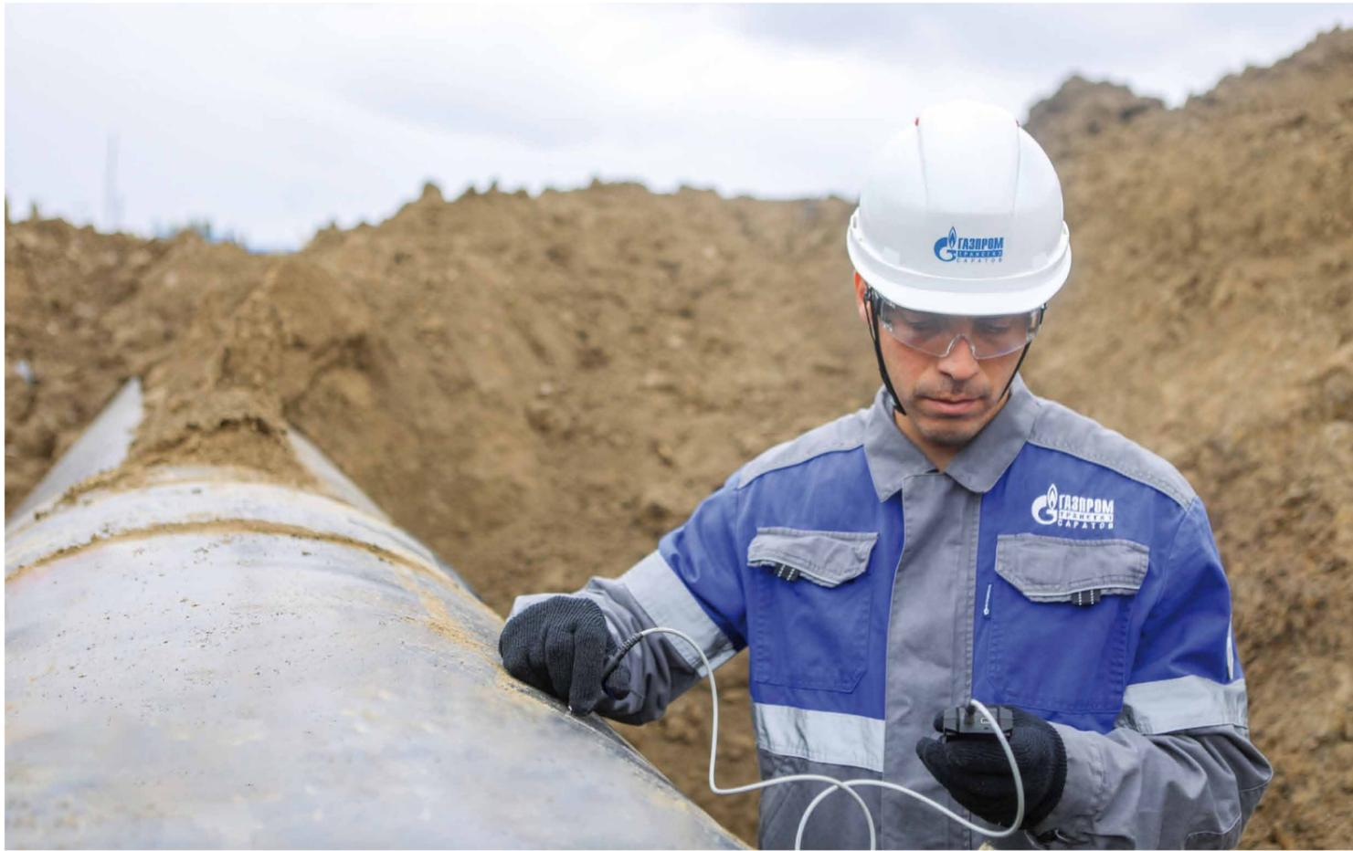
Контроль толщины защитного покрытия в шурфе
