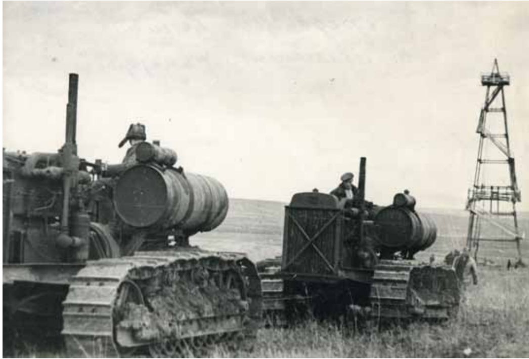
Перемещение вышки с помощью тракторов. Елшанское месторождение газа. 1942 г.
