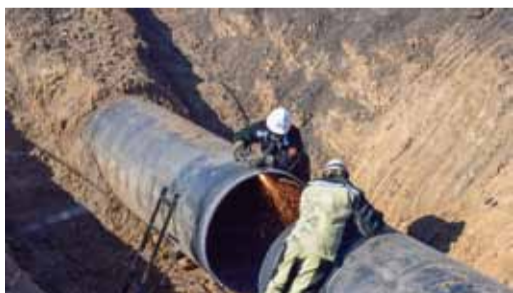
Подготовка к монтажу катушки
