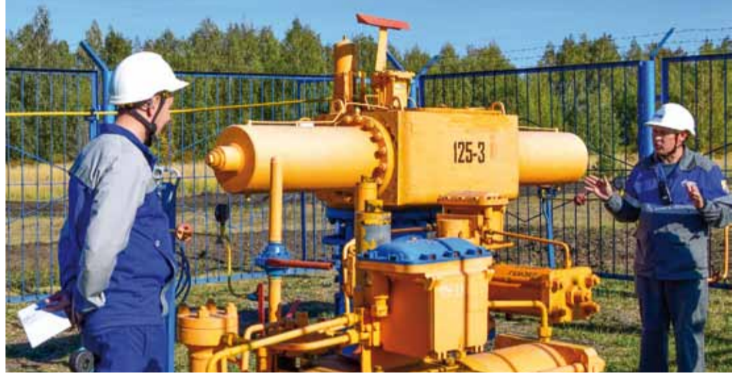
Проверка состояния запорно-регулирующей арматуры
