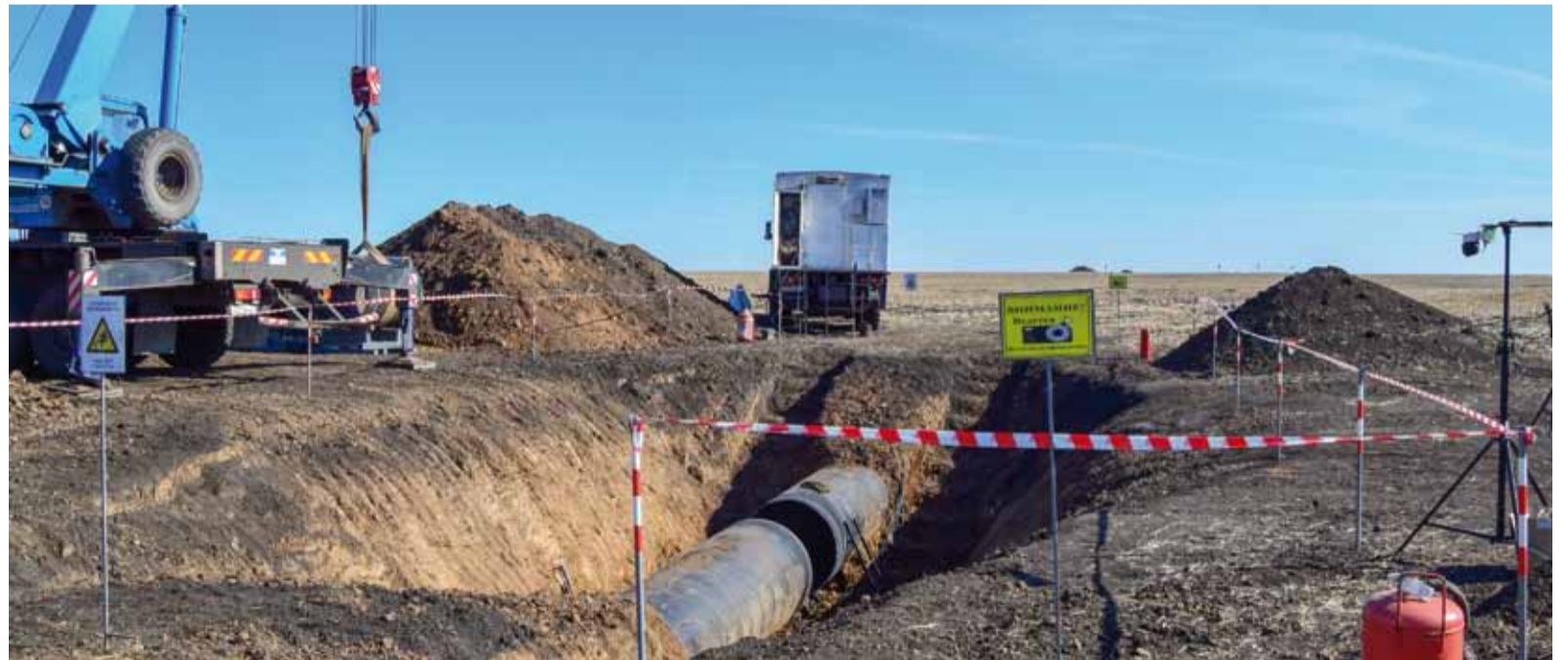
Члены комиссии посетили место проведения работ по устранению дефектов на магистральном газопроводе в Мещерском ЛПУМГ
