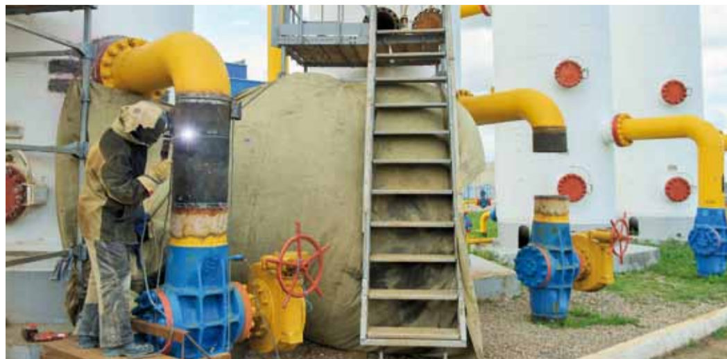
Огневые работы по вводу пылеуловителей в эксплуатацию
