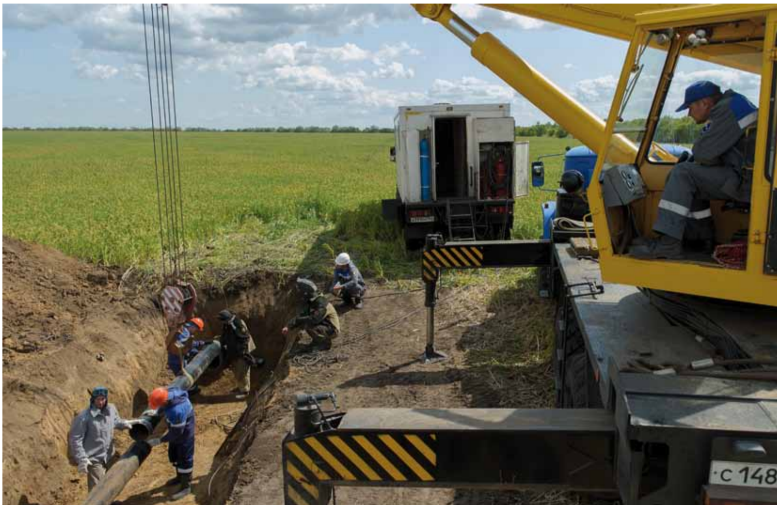
В рамках капитального ремонта заменены участки газопровода-отвода общей протяженностью более 300 метров
